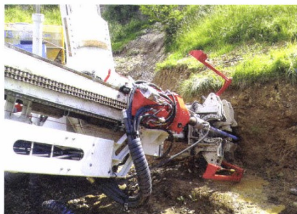
4. La fase di installazione di ancoraggi flottanti Sirive con barre composite da 3.000 kN
