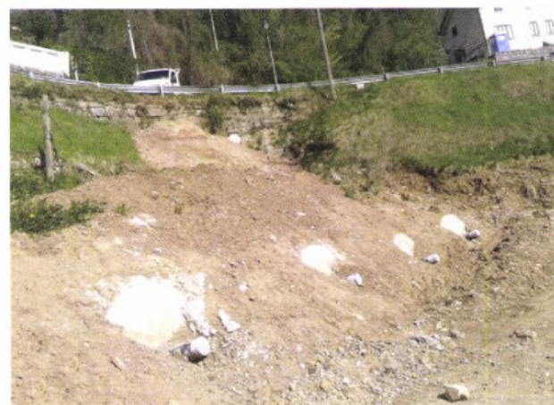
6. Il versante al termine dell'installazione
