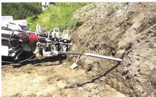
1. La fase di installazione di ancoraggi flottanti Sirive con barre composite da 3.000 kN
