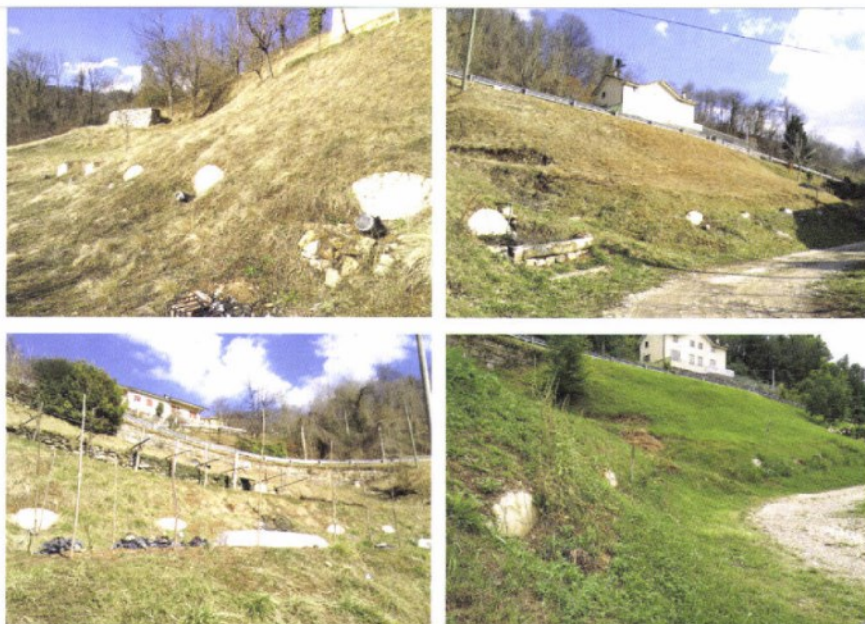
7A, 7B, 7C e 7D. Il versante rinverdito con integrazione ambientale ottimale delle opere: alcune piastre sono state volutamente lasciate parzialmente a vista per il monitoraggio di sollecitazioni e di spostamenti a cui sono sottoposte
