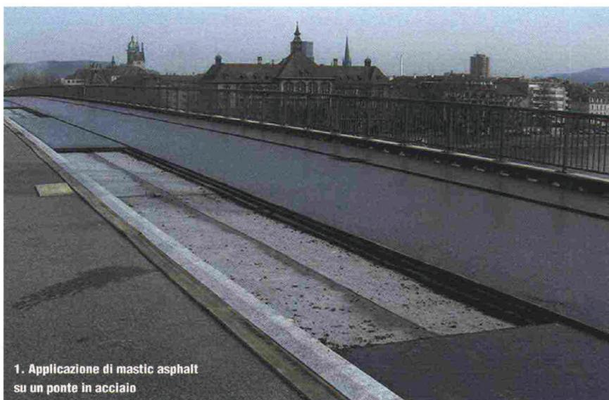
1. Applicazione di mastic asphalt su un ponte in acciaio
