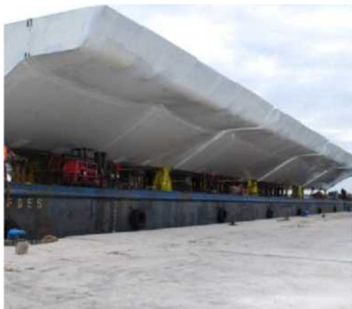
Lavori del Mose a Venezia, particolare delle paratoie a Malamocco
