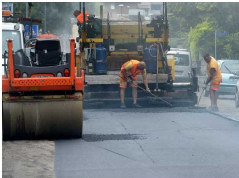
Lavori di asfaltatura in una strada di Verona FOTO MARCHIORI
