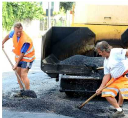
Operai al lavoro in un cantiere per l'asfaltatura di una strada
